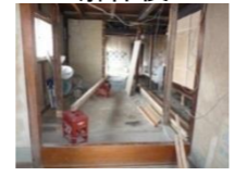
玄関から奥へと続く土間 解体後
